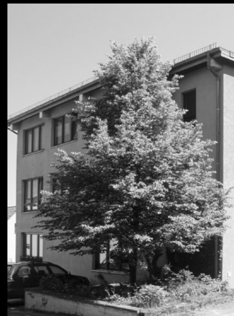
Sozialer Wohnungsbau Nr. 2: Rüdigerstraße
