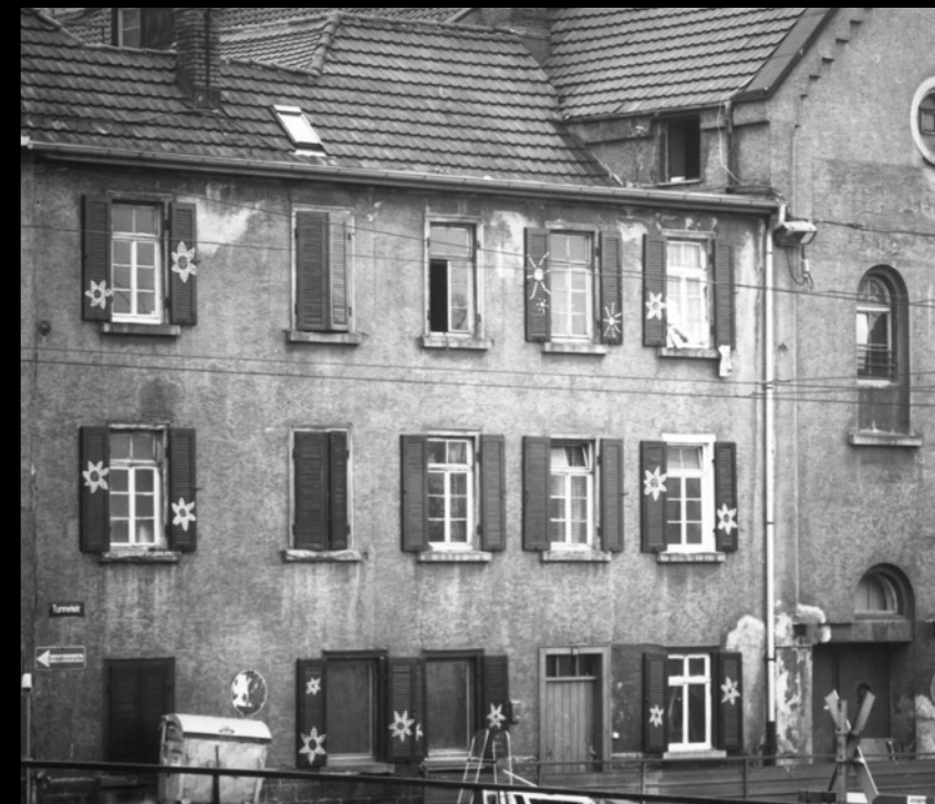
Die Tunnelstraße 18 in Stuttgart Feuerbach hat eine wechselvolle Geschichte.
